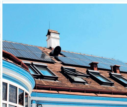
Herzstück der Klimaschutz-Maßnahmen ist die eigene, 120 Quadratmeter große Photovoltaik-Anlage, die auf drei Dachflächen verteilt angebracht wurde und jährlich 23.000 Kilowattstunden an Strom erzeugt
